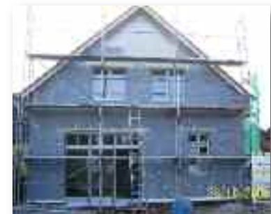
Fassadendämmung mit Wärmedämmverbundsystem
